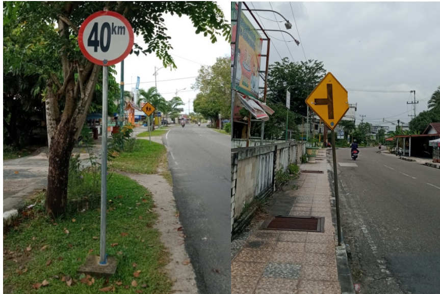
Gambar 3. Kondisi rambu baik dan rambu rusak
