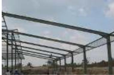
Gambar 3.2 Profil Baja *Wide Flange* (Baja konvensional).
