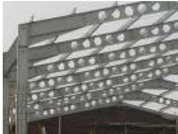
Gambar 3.3 Profil Baja *Hexagonal* (Baja konvensional).
